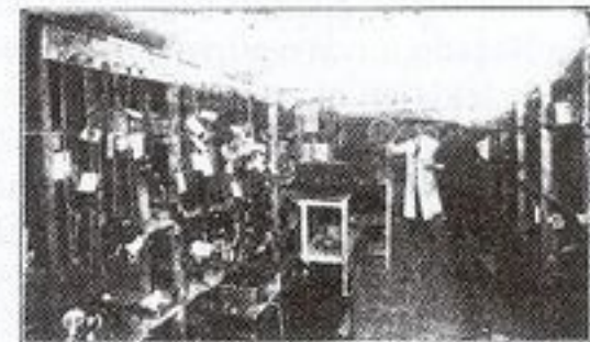
Vista parcial del depósito de auriculares y alta-vozes.
