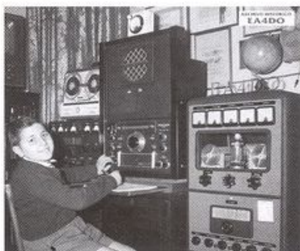
Isi, EA4-599.U, en 1957, ante el receptor National HRO-50 R (rack para el juego de bobinas intercambiables) de la estación EA4DO. A la izquierda "El tres de bastos" y a la derecha "La Pintora", transmisores construidos ambos por EA4DY.
